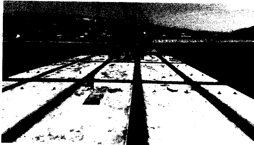
Foto 22: Concreto en juntas de losas en el cabezo de muelle.
